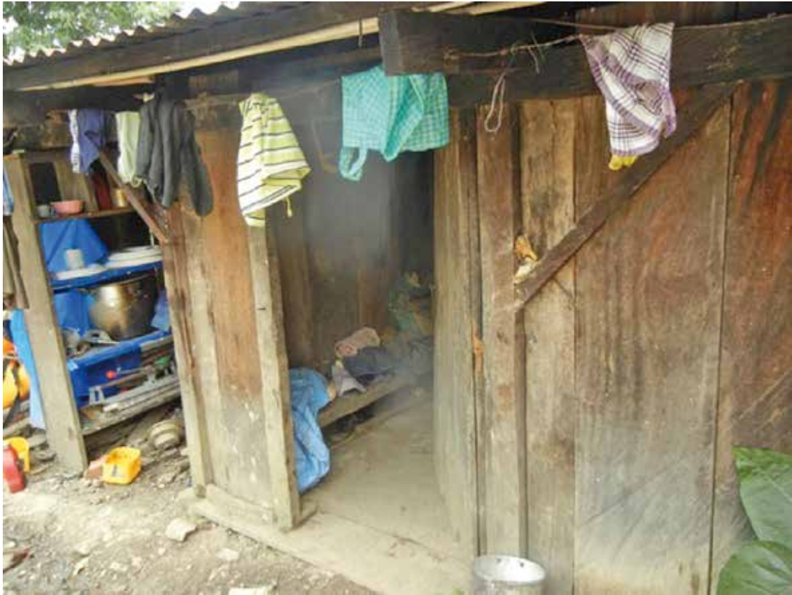
Trópico de Cochabamba, vivienda urbana sin servicios
